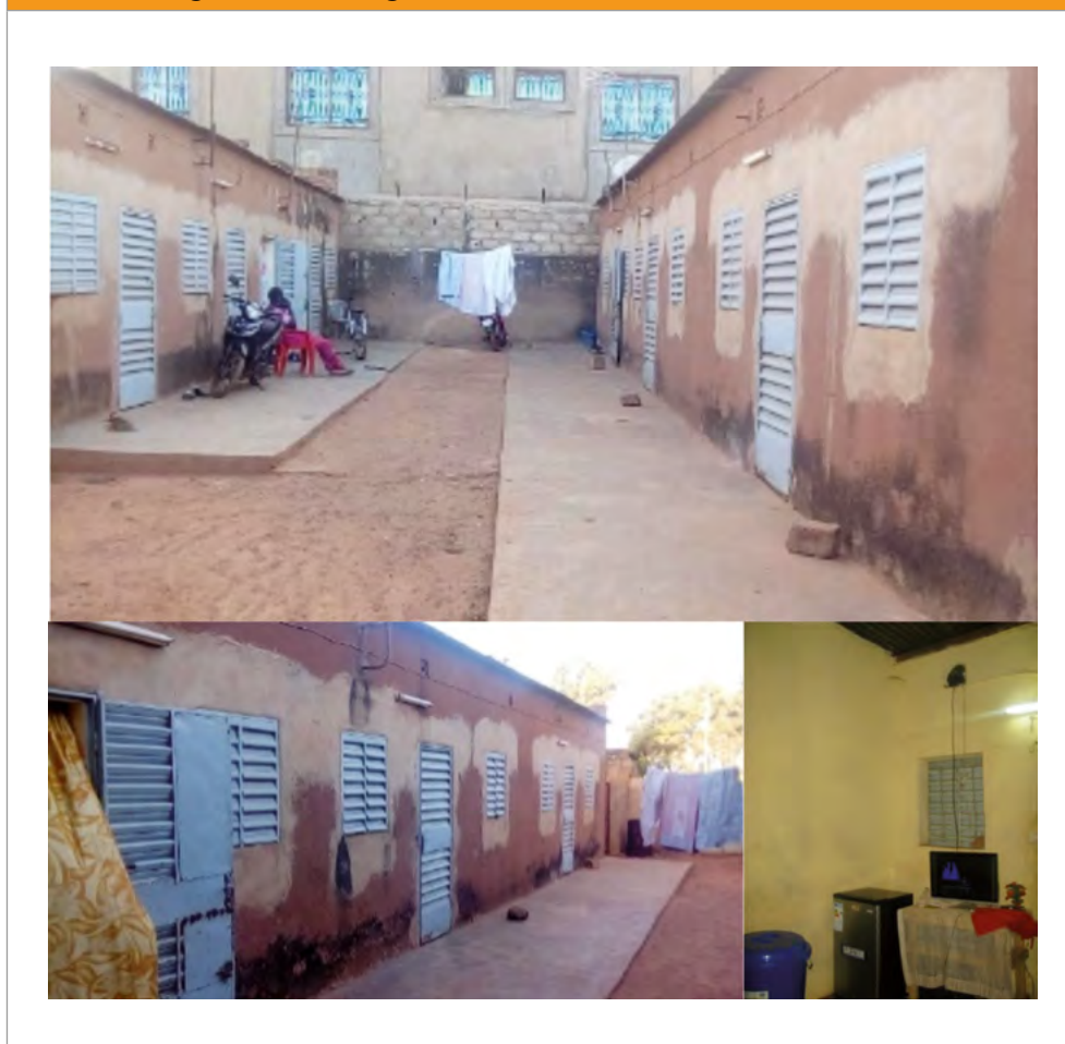
Figura 11. Fotografías edificación de varias viviendas
